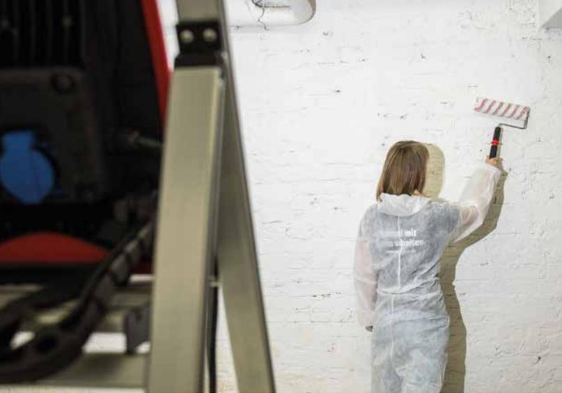
*So geht's: Baustrahler wird etwas höher positioniert, sodass der Schatten nicht auf den Arbeitsbereich fällt*
