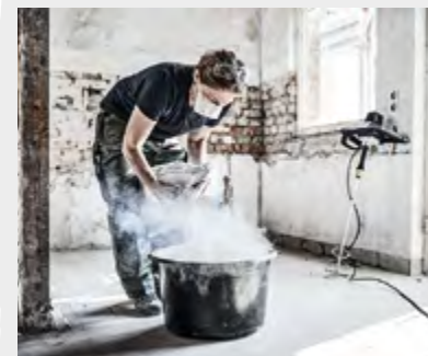
Beim Einfüllen und Anmischen von pulverartigen Materialien entsteht viel Staub
