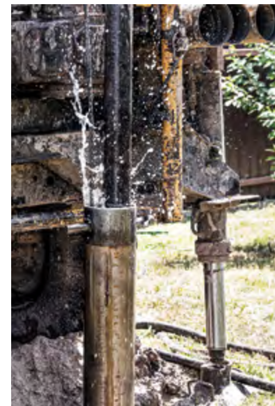
Der Brunnenbau benötigt viel Platz
