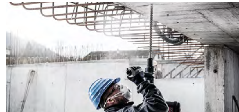
Der EXPERT Hammerbohrer im Einsatz
