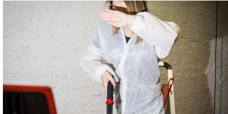
So nicht: Baustrahler blendet beim Arbeiten
