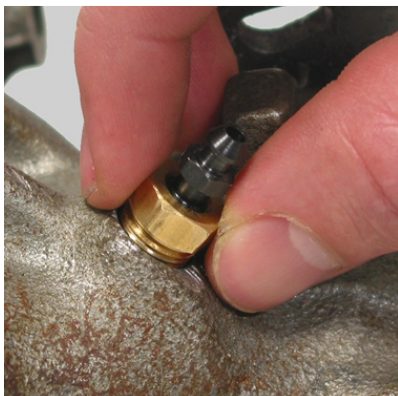
Ventileinsatz in das angefertigte Gewinde einsetzen
