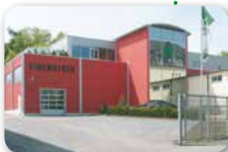
Hochregallager mit Verwaltung
