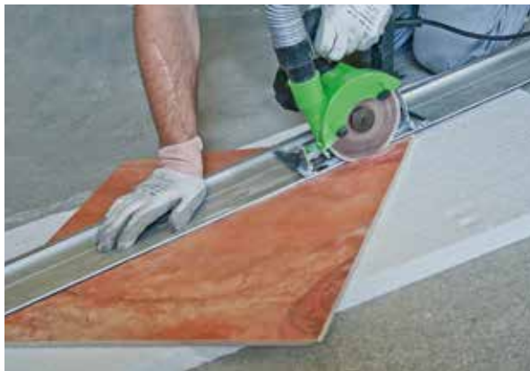
Maschine auf Führungsschiene (Zubehör) – als Anschlag für präzise Schnitte
