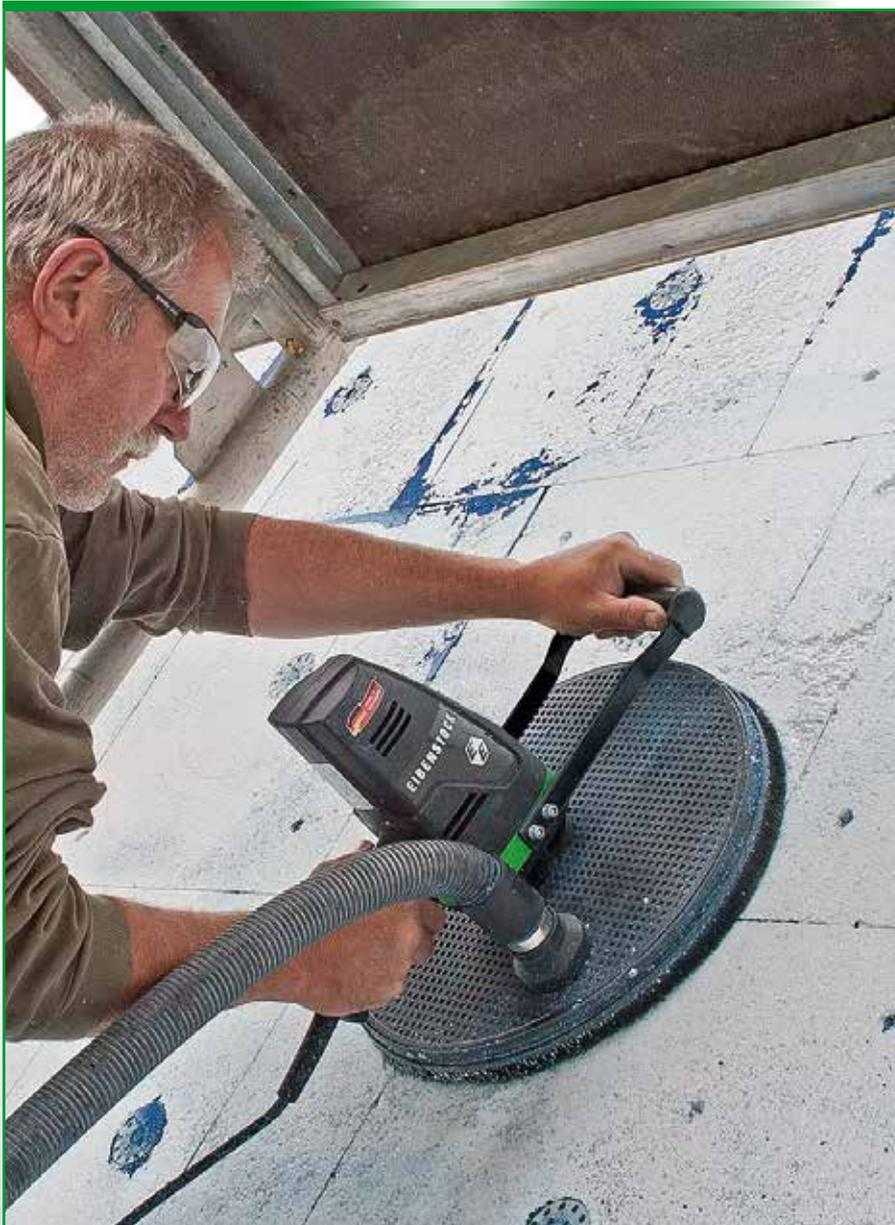
**Absaugung über Haube mit Bürstenkranz und gelochten Schleifteller** – verringert das Umherfliegen von Schleifeteilchen auf ein Minimum (Styropor, Mineral etc.), erspart aufwändiges Säubern der Baustelle
