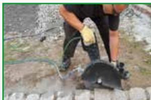
**Integrierte Wasserzuführung mit Durchflussregler**
