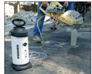
Trennschleifen im Straßenbau
